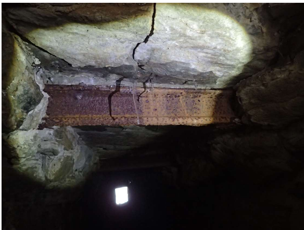
Foto 2: Prasklina ve stropě propustku
